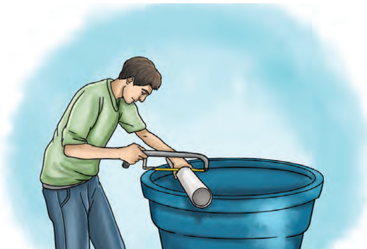
Serre os canos e conecte-os nas caixas
