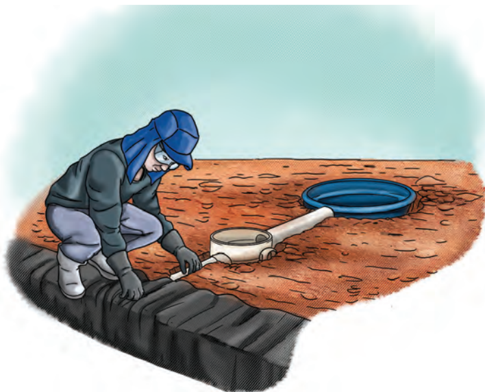
Caixa de decantação e caixa de gordura
